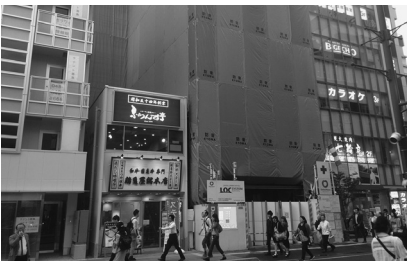
銀座通りで相次ぐペンシルビル建設
